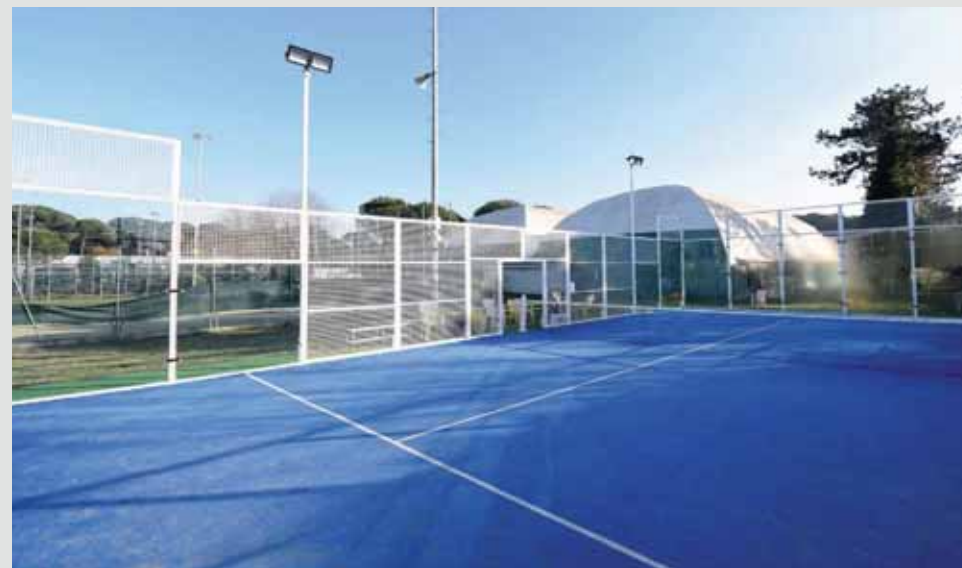
campi indoor con copertura pressostatica e outdoor
